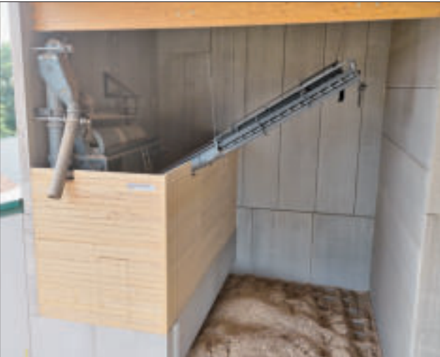
Ein Hackgutförderanlagen-System von Steiner aus Bayern sortiert Metallteile aus und siebt zu feine und zu grobe Bestandteile aus.
